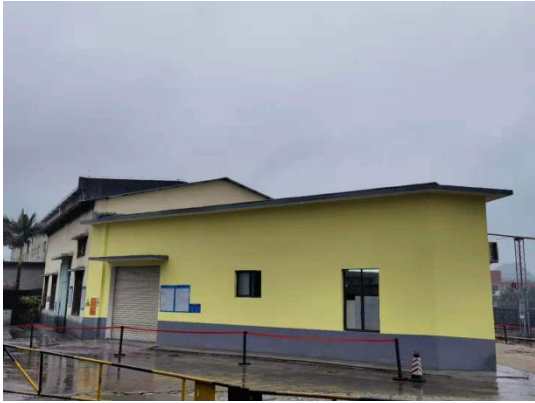
废油库（危废暂存间）
